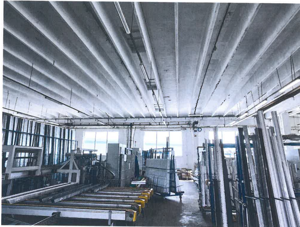
Foto interior hala productie 2, Tronson 1- Corp C16 -NC64623 an constructie1978- dispunere chesoane TT acoperis
