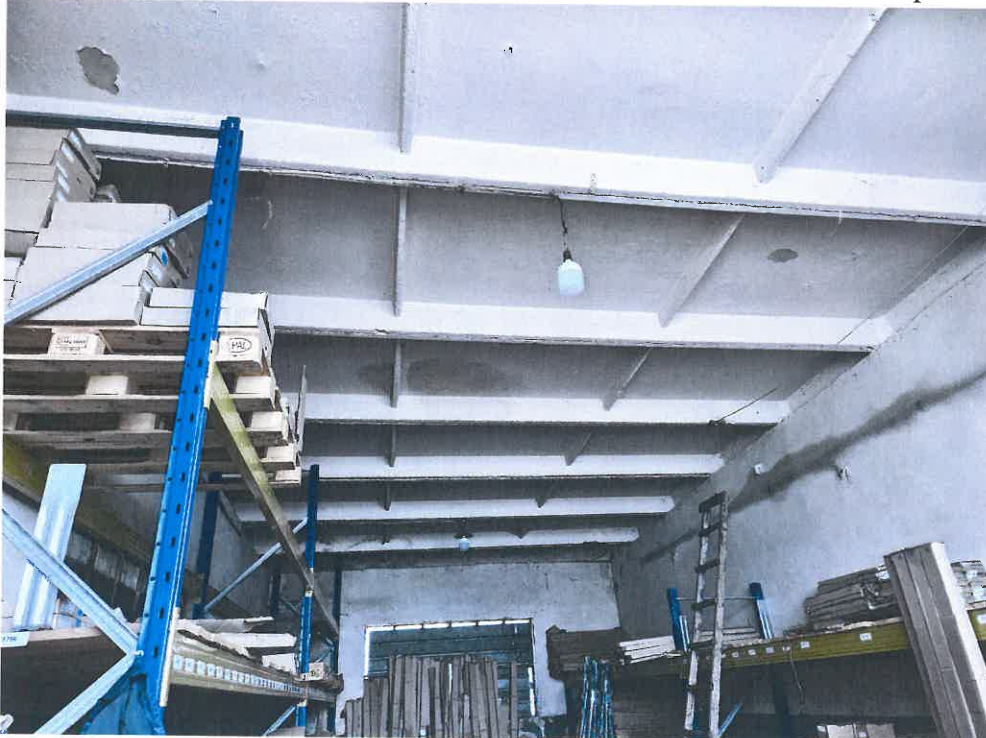
Foto interior magazie- Corp C3+C5-NC64623 an constructie1978- dispunere chesoane acoperis
