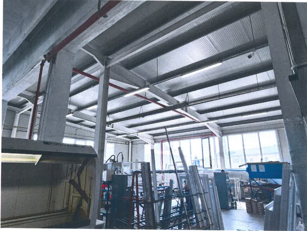
Foto interior hala productie 2, Tronson 3- Corp C16 -NC64623 an constructie2019- dispunere panouri multistrat acoperis
