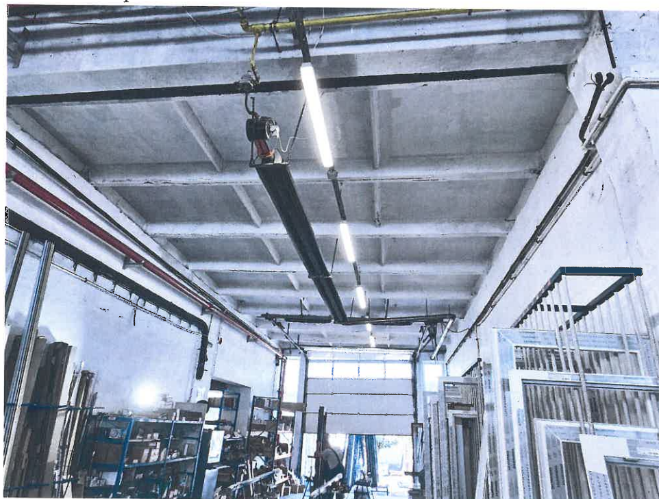
Foto interior hala productie 2, Tronson 2- Corp C16 -NC64623 an constructie1978- dispunere chesoane acoperis
